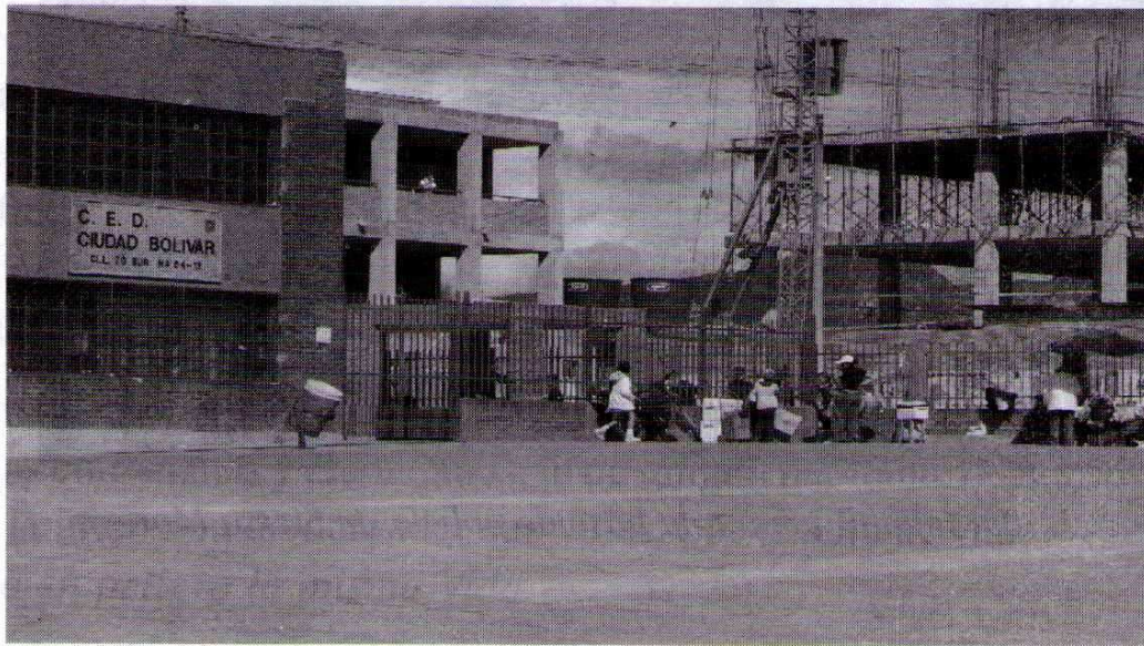
Construcción de la base en Sierra Morena junto a colegios
